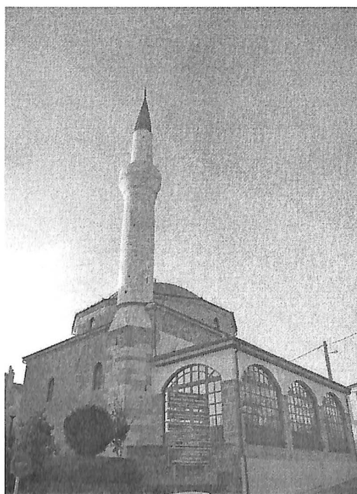
Εικ. 9. Το τέμενος μετά την ολοκλήρωση των εργασιών αποκατάστασης.
