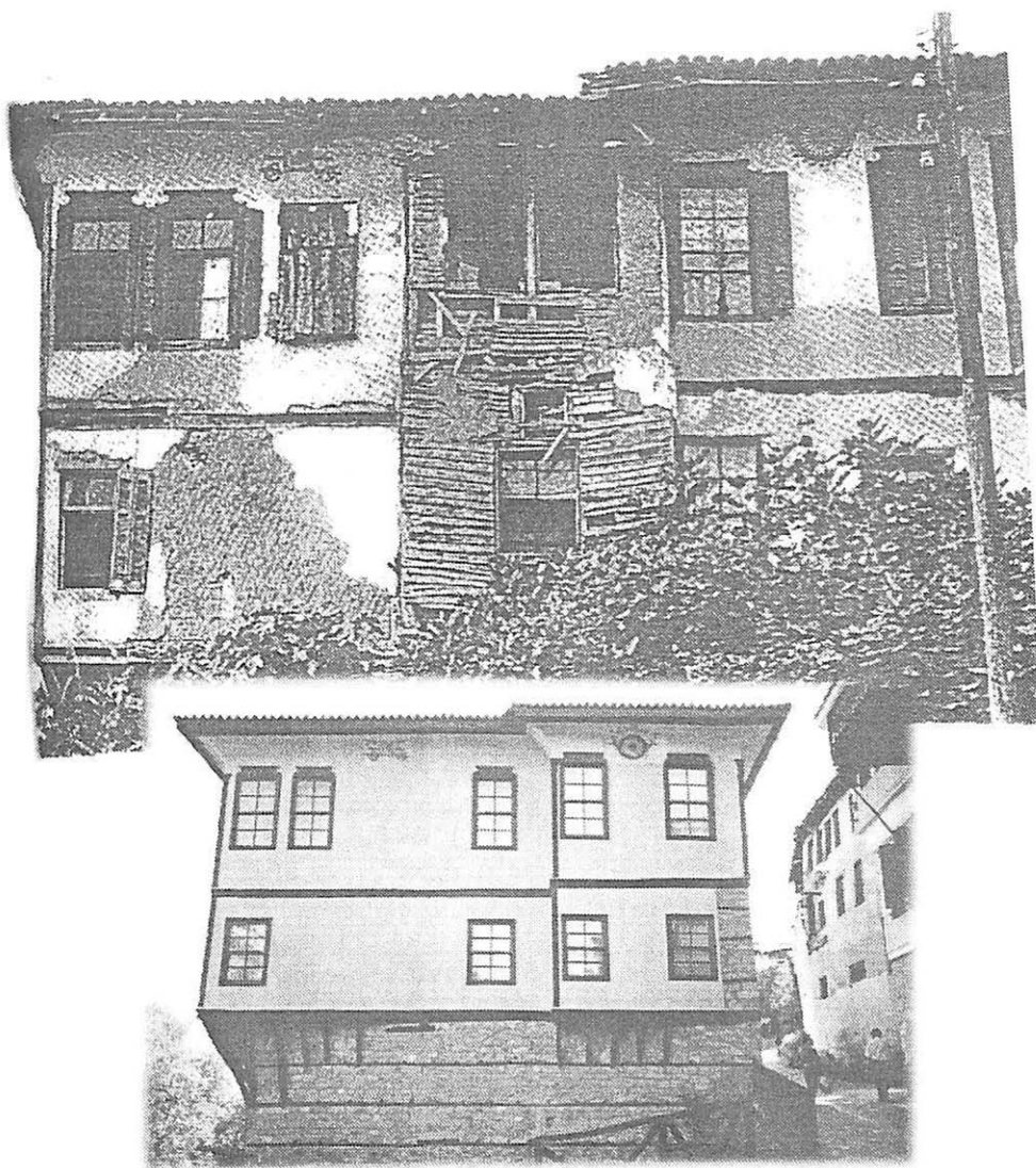
Μουσείο Αρχιτεκτονικής. Πριν και μετά την αναπαλαίωση.
