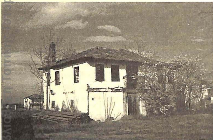
Κεφαλοκώρι. Δυόροφο πρώτο μισό 20ου αι. Σκεπή κεραμίδι, τοιχώματα πέτρα τούβλα
