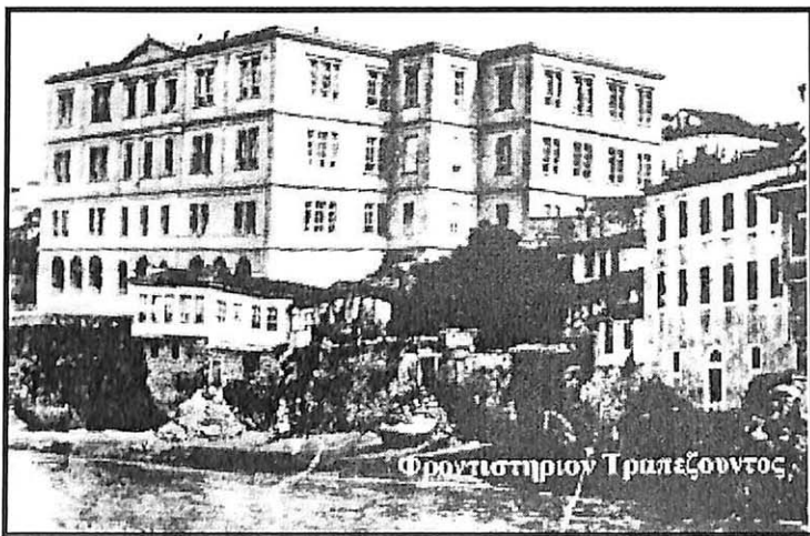
Φροντιστήριον Τραπεζούντος. Το 1864 το "Φροντιστήριο Τραπεζούντας" λειτούργησε σαν πλήρες γυμνάσιο αφού προηγουμένως μεταφέρθηκε από τη Μονή Περισστερώτα στο νέο επιβλητικό κτίριο. Ο Φιλολογικός Σύλλογος Κωνσταντινουπόλεως υποστήριξε πολλαπλώς την λειτουργία του "Φροντιστηρίου" απευθείας αλλά και μέσω του Φιλεκπαιδευτικού Συλλόγου "Ξενοφών" που υπήρξε ένας από τους θυγατρικούς του Συλλόγους.
