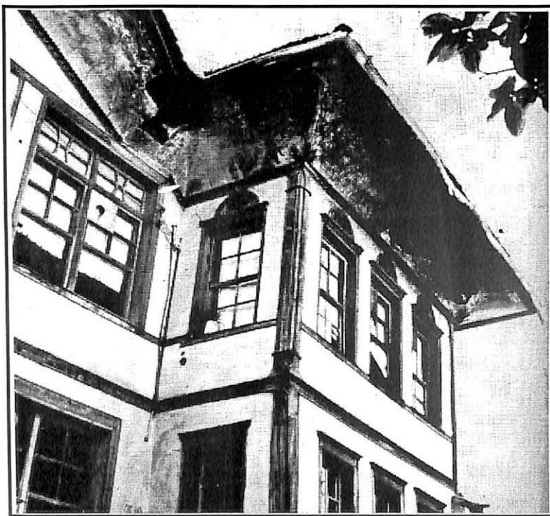
Καμπύλη διαμόρφωση γείσου "Αστρέας".
