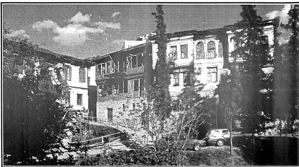
Αρχοντικά της Εβραϊκής συνοικίας προς την είσοδο του Τριποτάμου. Στο κέντρο το αρχοντικό Τσιαρτσάνη κατά τη διάρκεια εργασιών αποκατάστασης.
